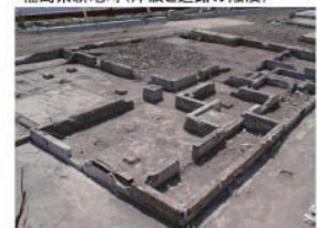
岩手県釜石市内(基礎だけになった住宅)
