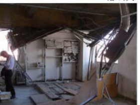
2階の様子(崩落した天井)
