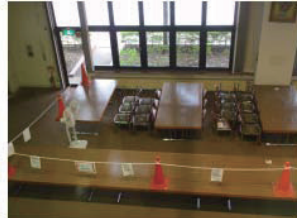
天井が崩落したため立ち入り禁止になった閲覧席
