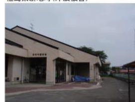
矢吹町立図書館(液状化による土地の陥没)
