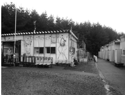
写真 1 最後の仮設住宅となった滝の里団地
