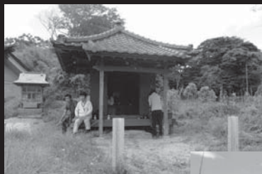
高台に建つ観音堂
