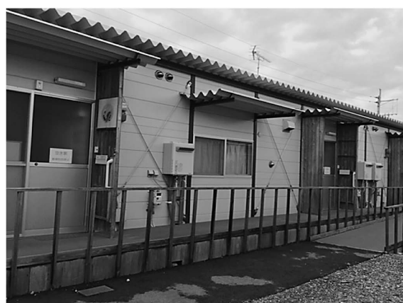
写真2 平成28年熊本地震 応急仮設住宅
