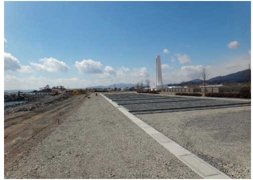
写真12 気仙沼市波路上明戸、波路上共葬墓地。2018年1月、内陸の波路上共葬墓地整備工事の一般競争入札は、村上工業（気仙沼市）が1億1100万円で落札。施工面積4953平方メートル、盛土5440立方メートル、植栽・雨水排水設備・園路広場・管理施設を整備したが、新墓所区画に墓石はない。2019年3月24日、筆者撮影。
