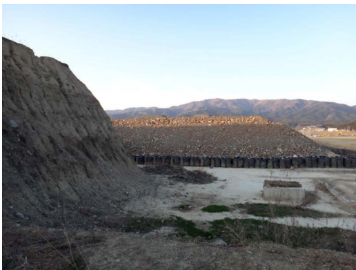
写真6 岩手県陸前高田市気仙町・県立高田病院（鉄筋コンクリ4階）解体跡地。1960年5月24日、チリ地震津波により床上浸水、1961年7月、災害復旧し本館新築・病棟増（病床151床）、1976年8月、全面改築。1998年11月、全面改修。2018年3月11日、14時46分、三陸沖地震発生、15時25分津波来襲、4階まで浸水し、職員6人・患者16人死亡。2018年3月1日、1.5キロ離れた標高51メートルの高台に移転、鉄筋コンクリ2階建ての新病院（病床60床）で診療開始。2018年3月31日、筆者撮影。
