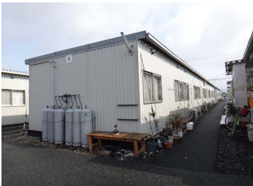
写真1 宮城県気仙沼市上田中二丁目の反松公園（敷地面積9,224平方メートル）に設置された応急仮設住宅団地。6戸長屋が16棟、合計96戸が入居可能な応急プレハブ仮設住宅が並んでいる。2020年3月末までに解体・撤去の予定。2019年3月24日、筆者撮影。
