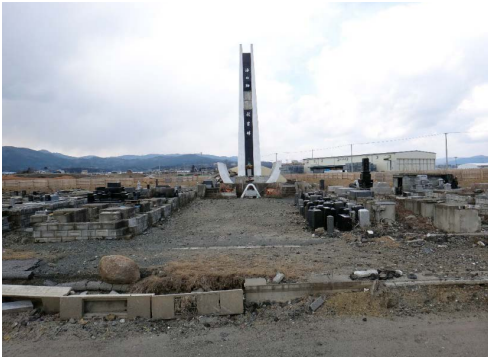
写真11 気仙沼市波路上明戸、海岸沿いの波路上共葬墓地と倒壊しなかった「海の殉職者慰霊塔」。墓石は倒壊し遺骨も流出。放置された墓所は、無縁仏として撤去するとの看板がたてられた。2017年4月2日、筆者撮影。
