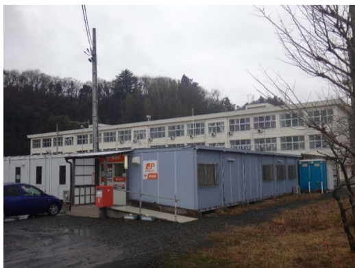
写真9 宮城県東松島市松島市野蒜（のびる）字亀岡の野蒜小学校（3階建て）の敷地（9,310㎡）に設けられた野蒜郵便局。元の郵便局は津波で流失。野蒜小学校の上層階に避難した住民は助かった。2018年4月16日、野蒜郵便局は廃止、高台に移転し野蒜ヶ丘郵便局として開業。野蒜小学校も高台に移転。住民は帰還していない。2017年3月27日、筆者撮影。
