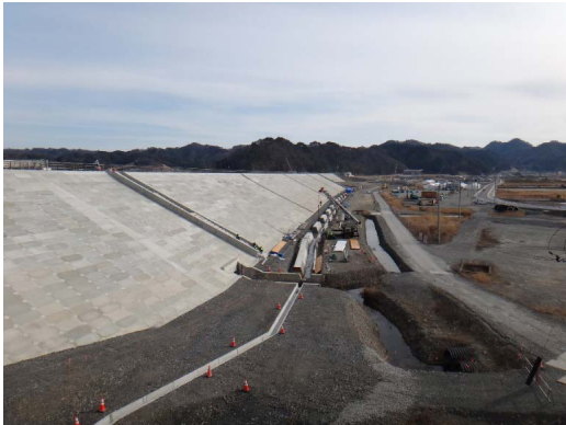
写真4 岩手県釜石市片岸地区の片岸防潮堤と区画整理・盛土による宅地整備中の片岸町。被災前から海面6.4mの防潮堤の上に、鶴住居川水門（長さ236m）と一体化した片岸防潮堤（高さ14.5m、延長818m）を建設。鋼鉄製の杭1100本を深さ30mまで打ち込んだ。2019年3月に防潮堤完成、水門は未完成。工費は、水門188億円、防潮堤123億円、合計311億円。23ha片岸町の区画整理は未完成。震災時の862人・332世帯から2015年の195人・122世帯に激減。2019年3月19日、筆者撮影。
