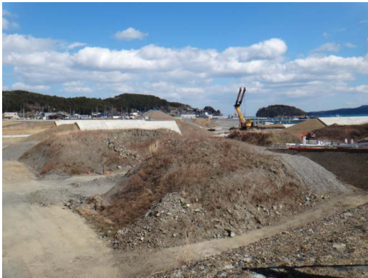
写真5 南三陸町志津川汐見町の高台化嵩上げ工事：15.5mの津波で南三陸町の6割が全半壊。10トン積みダンプカー60万台分の土砂を搬入、土地を10m嵩上げする。2011年2月の志津川地区の人口8,213人・2,723世帯から、2019年3月末の5,249人・2,071世帯に減少。2019年3月24日、筆者撮影。
