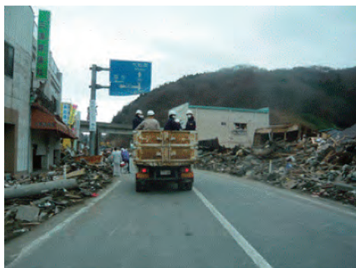
写真2 道路啓開作業中の工事車両（平成23年3月15日、釜石市）
