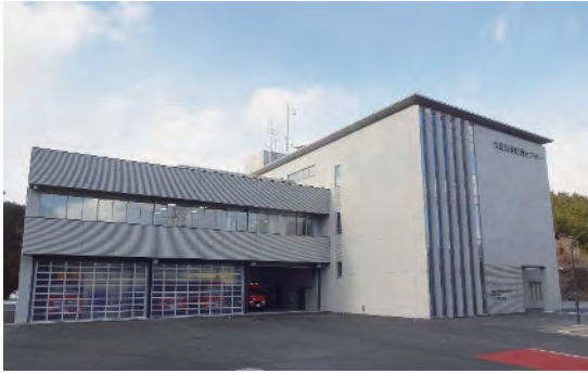
写真11 高台に完成した防災センター
