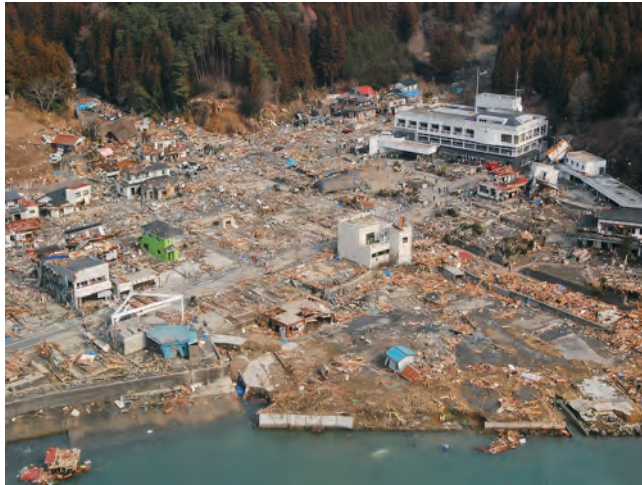
写真5 雄勝地区中心部
