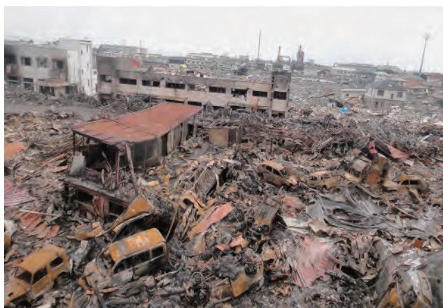
写真4 門脇地区の火災被害
