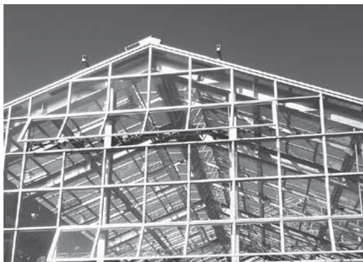
写真1 新しく建設されたA漁協の養殖場を見上げる
