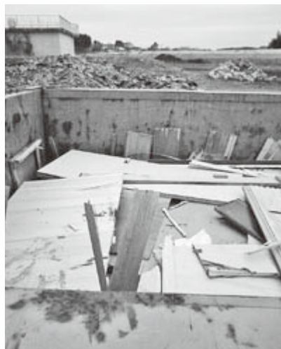
図2 木製家具などの木くずは、散乱防止のため仮置き場に置かれたコンテナの中に集められている。
