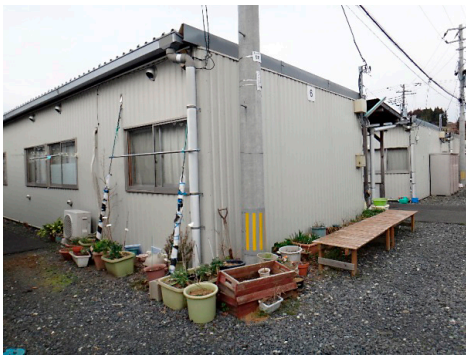
写真9 気仙沼市上田中二丁目の反松公園（敷地面積9,224平方メートル）に設置された応急仮設住宅団地。6戸長屋が16棟、合計96戸が入居可能な応急プレハブ仮設住宅が並んでいる。敷地には余裕があり、空き地は駐車場となっている。2018年4月1日、筆者撮影。
