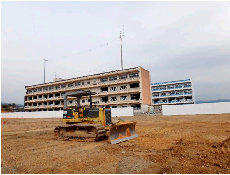
写真30 気仙沼市波路上崎野，県立気仙沼向洋高。気仙沼市は2015年5月に旧南校舎の保存を決定，2017年1月，解体予定だった北校舎など校舎全体を保存する変更を行った。ここには映像室・防災教育体験室などを備えた伝承館も建設される予定。この旧校舎保存，伝承館建設の総事業費は11億8600万円。2018年4月1日，筆者撮影。
