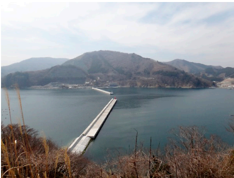
写真21 宮城県女川町女川港の湾口防波堤、手前は北防波堤で全長388m、奥は南防波堤366m。2012年7月着工、2016年3月末に完成。総事業費81億円。東日本大震災の時期に、女川港には津波を想定した県内唯一の湾口防波堤があったが、津波で崩壊。そこで、全長や高さはほぼ同じで、潜堤部分の対津波強化を図った。2018年3月27日、筆者撮影。
