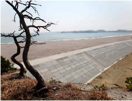
写真20 宮城県東松島市洲崎海岸（野蒜海水浴場）、海岸堤防の復旧延長は2.9km、海拔7.2m。1個2tのコンクリートブロックを組み合わせ、堤防を乗り越えた津波の引き波にも耐える構造となっている。事業経費108億円、2017年度末に完成。右奥、堤防背後の県道奥松島公園線は、本土と陸繋島の宮戸島宮戸地区との交通を確保する道路で、6.2m 高上げされる。2018年3月26日、筆者撮影。
