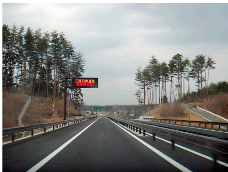
写真5 三陸自動車道路。宮城県・岩手県の沿岸の自動車交通網の基軸となるのが三陸自動車道路である。復興に必要な物資輸送を担うトラックが頻繁に通行する高速道路で、通行料は無料で運営されている。ただし、三陸自動車道路は、2018年4月現在、全通しておらず、至る所で、一般道に降りなければならない。2018年3月29日、筆者撮影。
