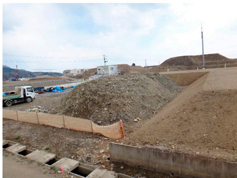
写真24 気仙沼市松崎片浜、津波対策として嵩上げ高台化工事が行われているが、震災6年後でも完成には程遠い。2017年12月20日、気仙沼市は、東日本大震災で被災した松崎片浜地区に小規模区域の土地区画整理事業（敷地整序型）を導入し、防災集団移転事業で換地によって土地を集約化、市が買取った住宅地を産業用地に転換するとした。事業費は2億円の見込みで、国の復興交付金を活用し、2018年7月着工、2020年3月末の完成を目指す。それまでに、土地嵩上げ高台化工事が完了しなければ、計画は頓挫する。2017年4月2日、筆者撮影。
