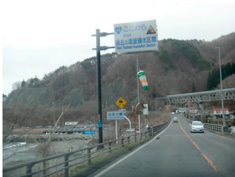
写真4 岩手県九戸郡野田村下安家、復旧された国道45号線の2011年3月11日の津波浸水区の表示、左奥は下安家漁港。奥右の架橋は、2014年に宮古-久慈間71キロが復旧した三陸鉄道北リアス線の架橋。2017年4月1日、筆者撮影。
