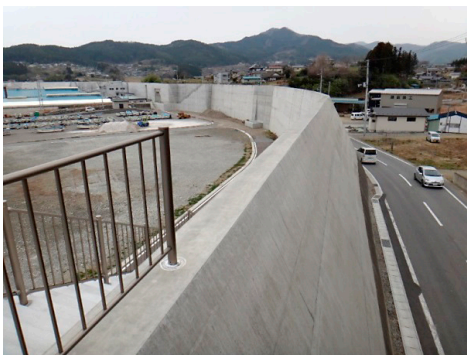
写真16 岩手県大船渡市末崎町、門之浜湾に沿って完成した海拔12.8mの巨大防潮堤。岩手県は、2013年7月に着工、工期は2年9か月遅れて2018年に完成。津波浸水区域だった末崎町字大田の分譲地の地価は、2018年11月現在、1平方メートル当たり1万円と安価である。2018年3月29日、筆者撮影。
