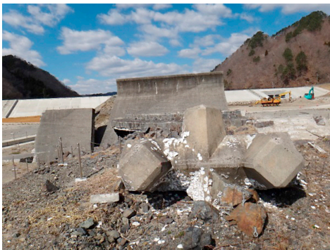
写真17 岩手県下閉伊郡田野畑村岸、津波によって決壊した「明戸海岸防潮堤」(震災遺構)。後方の内陸側には2016年3月完成した堤高12mの巨大防潮堤が見える。旧防潮堤は、17mの津波で破壊され、波よけブロックで囲まれた形状で残された。震災遺構として、2016年末の整備完了までに、通路や駐車場の整備に総事業費1億7000万円がかかった。2018年3月29日、筆者撮影。
