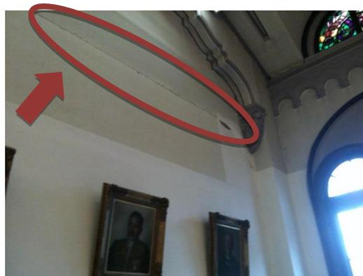
写真4 大閲覧室（壁のひび割れ）
