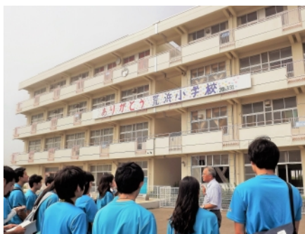
震災遺構となった荒浜小学校にて
