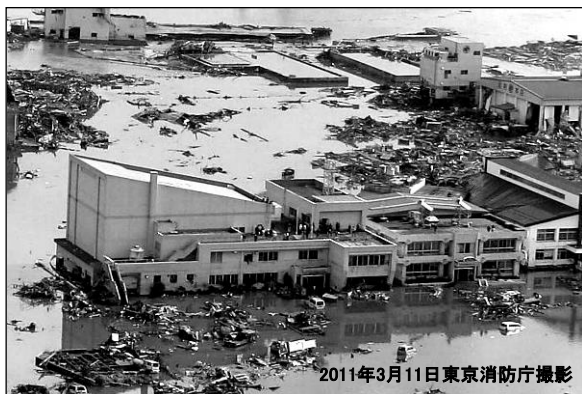
図7 津波避難施設(公民館)周辺の津波浸水状況 5)
