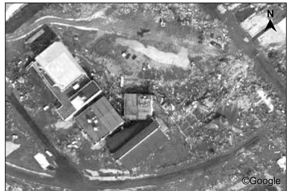
図3 震災後の航空写真（2011年3月30日撮影）
