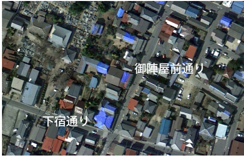
写真1 真壁 2011/3/29 の屋根損傷状況 (google earth pro)
