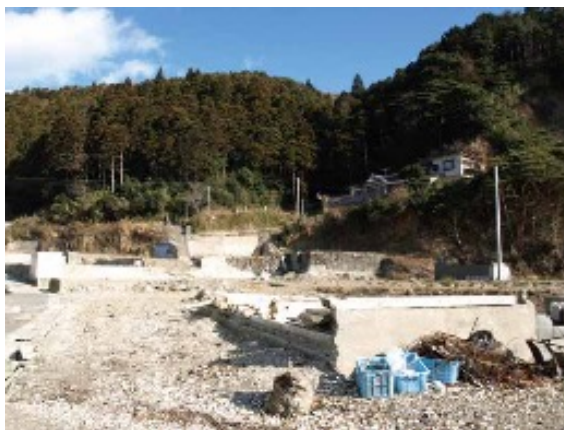
写真1 被害を受けた宅地
