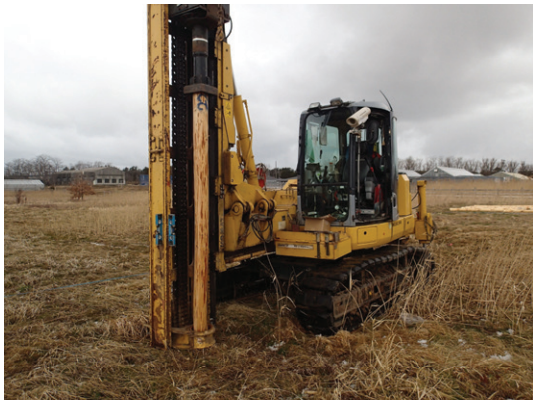
図1 FCでの木杭打設試験(26年度)
