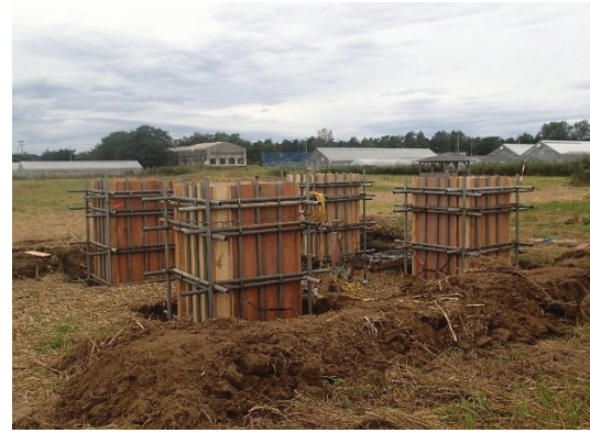
図2 杭頭部へのコンクリートの打設(27年度)
