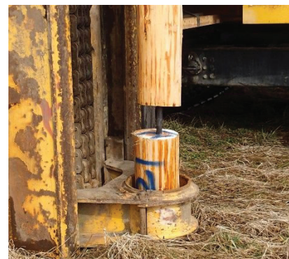
図5 木杭の打ち継ぎ部
