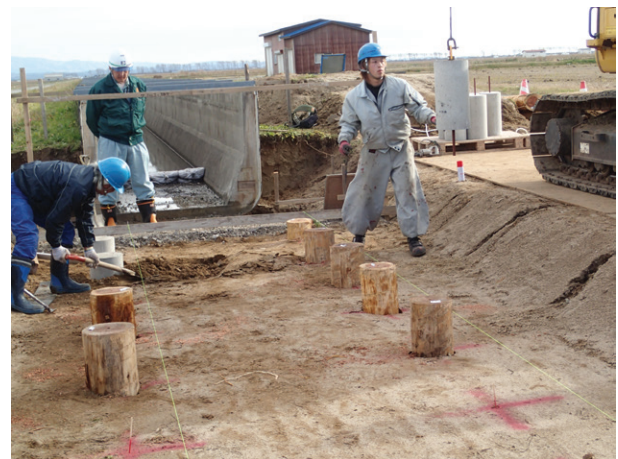
図 12 用水路改修工事のける木杭基礎の試験施工
