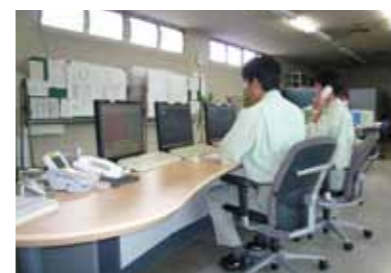
24時間監視システム
