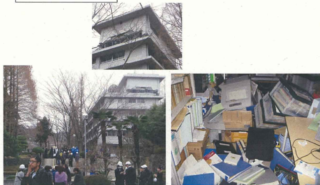
事務局のある研究棟が大きく破損(9月1日現在も立入禁止)
