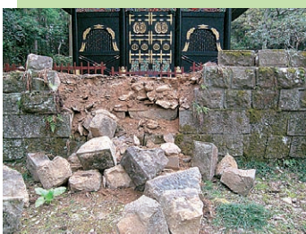
写真上: 妙雲界廟石燈籠の倒壊 下: 善応殿前の石垣・土塁崩落
