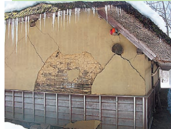
写真: 外土壁の亀裂と剥離
