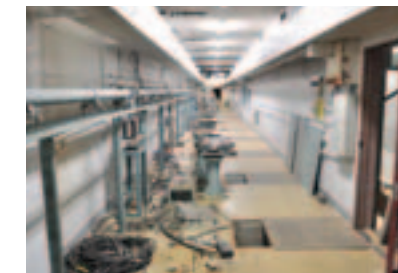
LDM及び放射線遮蔽用コンクリートブロックその他を撤去した後の電子シンクロトロン
