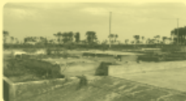
▼ 津波で流された「みどり工房若林」跡
