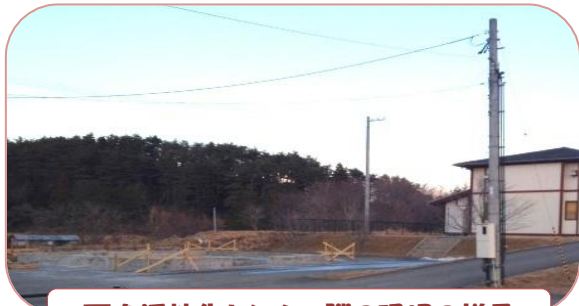
石泉活性化センター隣の現場の様子
