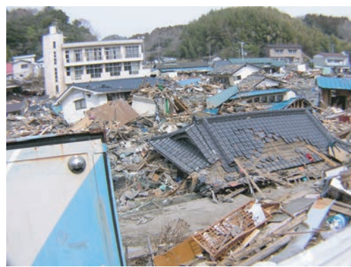
室浜の被災状況
