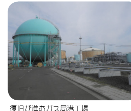
復旧が進むガス局港工場
