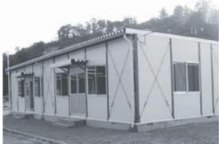
▲浦戸地区仮設施設整備事業により、ノリ生産グループの共同作業場が完成
