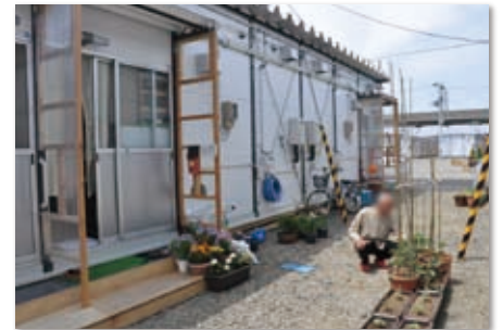
市内設置の応急仮設住宅
