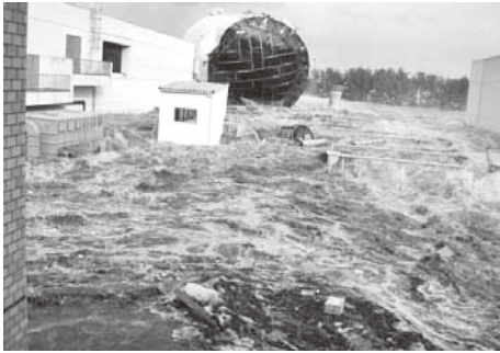
▲ガスタンクは浄化センターから1km以上も西に流されました（県南浄化センター）
