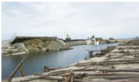
防潮堤の仮復旧が進む荒浜海岸
