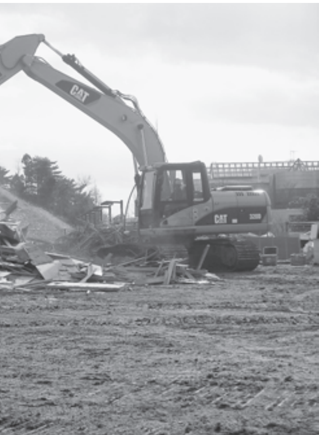
▲処理が進む災害ごみ（中央公園北側緑地）
