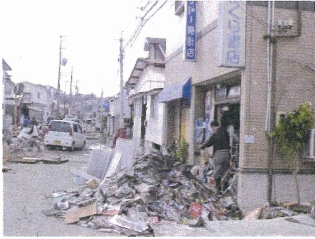
▲藤倉地区では著しく地盤が沈下
